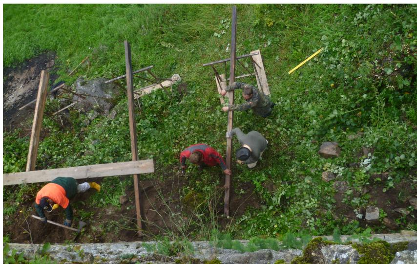
Links: Es wird ein zehn Meter breites Gerüst für die fünf Meter hohe, Einsturz gefährdete Mauer erstellt.
