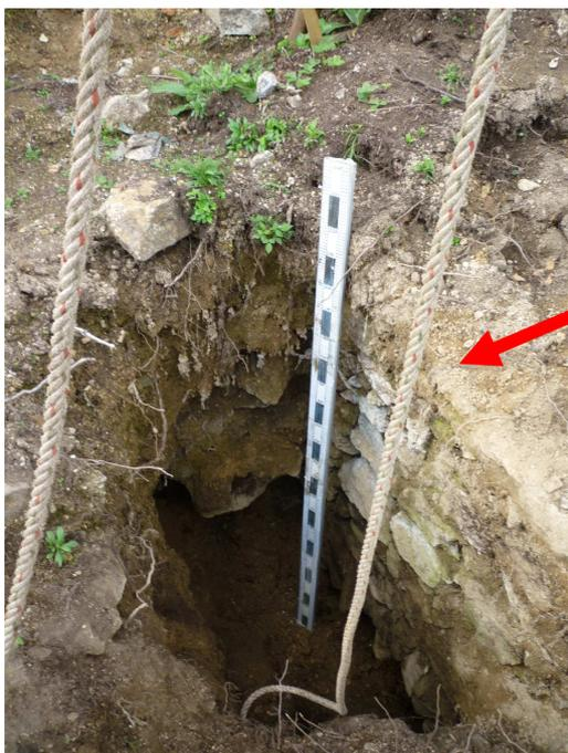
*Bild links:* Das Loch am dritten Kellergewölbe hat eine Tiefe von ungefähr 2,20m. Der **oberste Stein** auf der rechten Mauer hat den Anschein, dass es ein „Abschlussstein“ oder „Türschwellestein“ sein könnte, da er bei einer Länge von ca. 1,50 m einen Abschluss darstellt.
