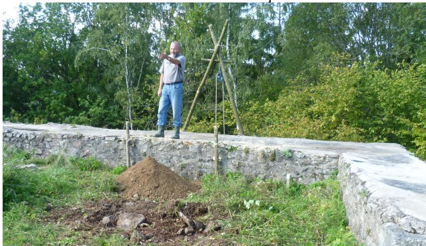
Nachdem auf den Kellergewölben die Wurzelstöcke entfernt worden sind und dabei größere Unebenheiten entstanden, **füllen wir diese mit Lehmerde auf**. Zukünftig wird es einfacher werden diese ebene Fläche zu pflegen und zu mähen.
